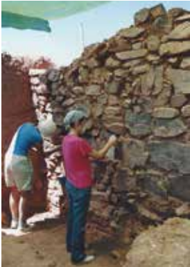
Trabajos de consolidación de morteros en la muralla del siglo V a.C.
