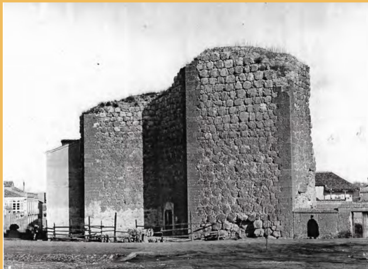
Puerta de Bejanque (1884). Fotografía de la Real Academia de la Historia localizada por M.A. López Trujillo (1994).
