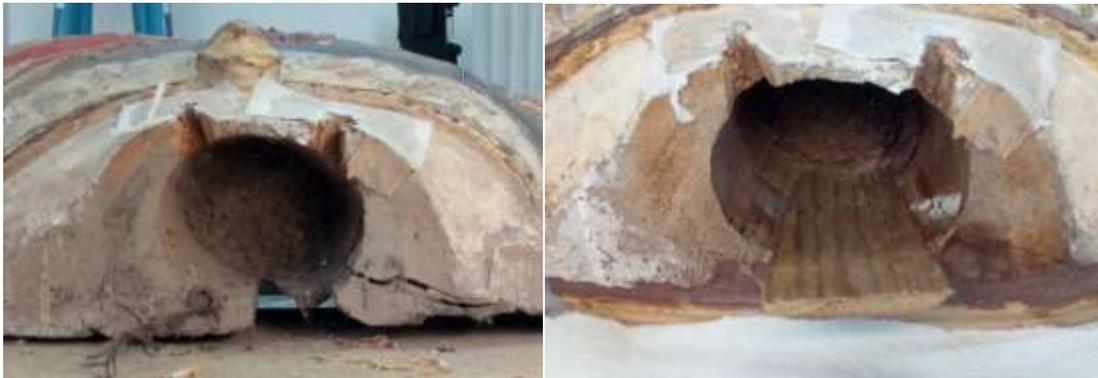
Limpieza del hueco y estabilización del soporte en la zona debilitada. Sellado de grietas, realización de piezas de madera de refuerzo en el interior.
