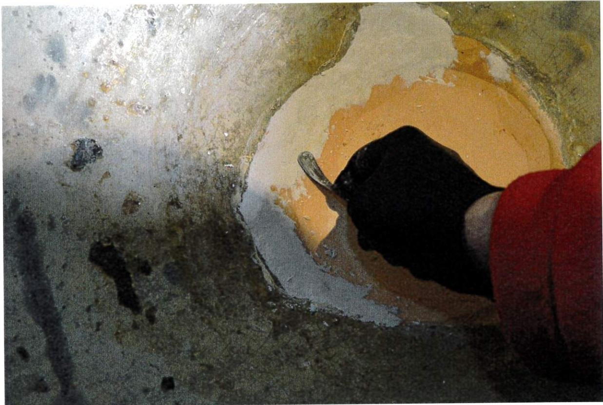
Proceso de aplicación de la escayola sobre el mortero de la intervención anterior.
