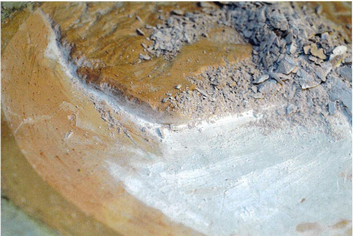
Fondo de la pila tras la retirada del exceso de mortero.
